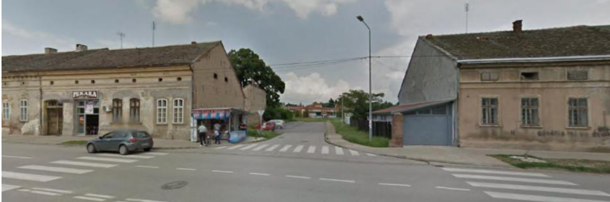
Илустрација 17– постојеће стање - непрекинути низ објеката у Булевару Константина Великог
