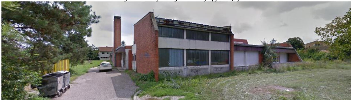
Илустрација 29a: ЗОНА b1- Предшколска установа „Маслачак“ - западни изглед са економским улазом у објекат са задње стране
