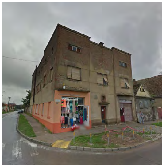
Илустрација 6 – Објекат у Булевару Арсенија Чарнојевића бр. 49
